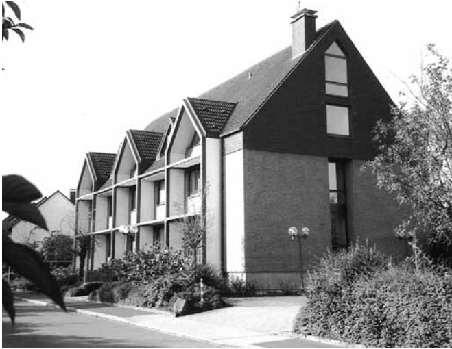
Das Bürohaus in der Lennestraße 75 in Hagen
